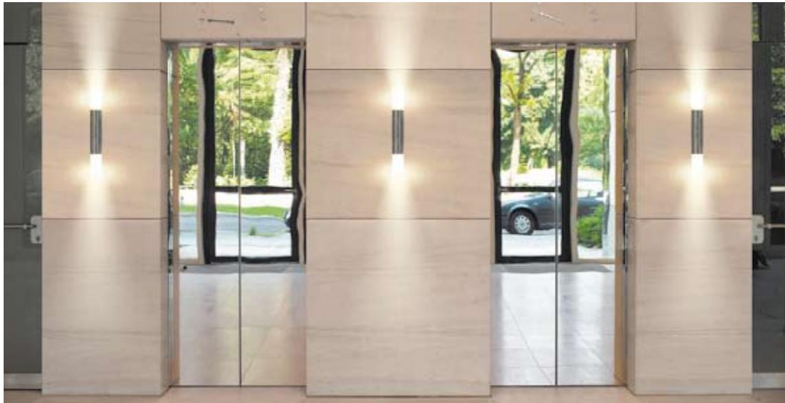
Leuchten mit eingebauten Reflektoren für einen gerichteten und einen freistrahlen- den Lichtanteil. Zwei mit dem Glas verbundene Reflektoren aus Reinst-Aluminium richten das Hauptlicht nach oben und nach unten. Der freistrah- lende, zwischen Reflektor und Lampensockel austretende Lichtanteil wird weich und gleichmäßig verteilt.
