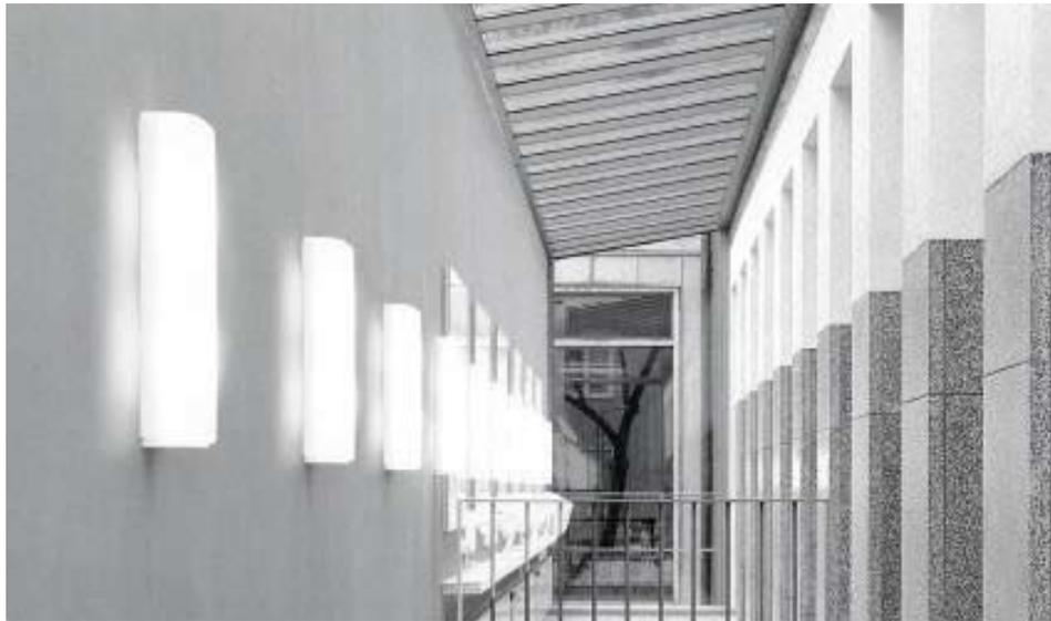
Geschlossene Wandleuchten in vier Größen mit unterschiedlichen Lichtleistungen für Allgebrauchslampen und Leuchtstofflampen.
